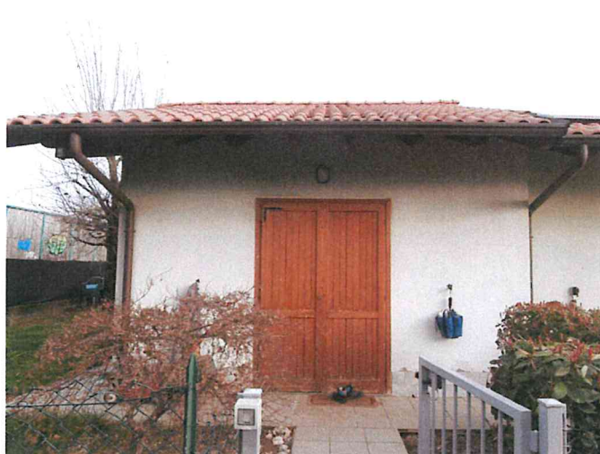
Foto 02 - Alloggio - Prospetto Sud.JPG
