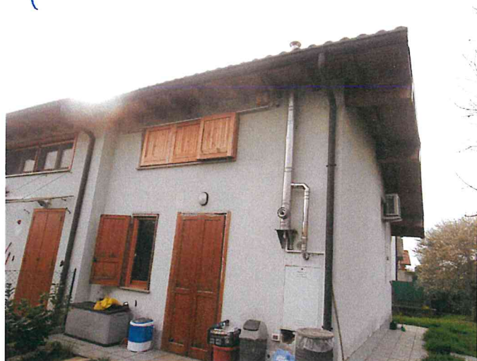
Foto 06 - Alloggio - Prospetto Nord.JPG
